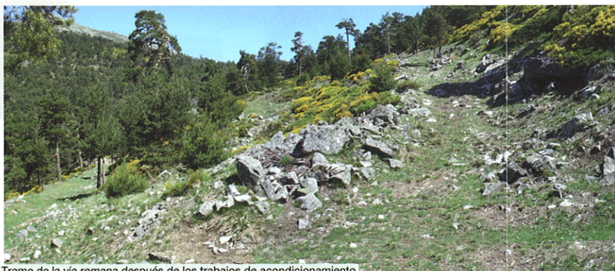
Tramo de la vía romana después de los trabajos de acondicionamiento
